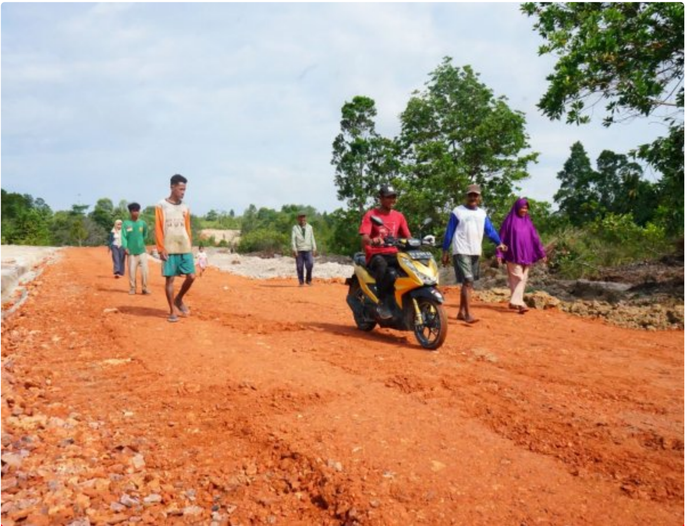
Pembukaan Jalan Rampung 100 Persen, Warga Berbondong-Bondong Datang Ke Lokasi
